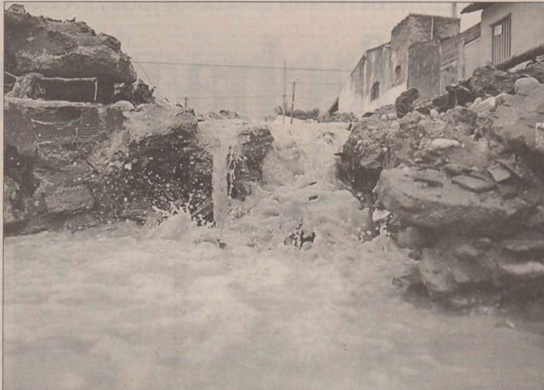
Na rua da Consolação, no conjunto Alvorada, o volume d'água também foi intenso e preocupou os moradores de lá
