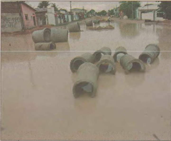
Tubulações espalhadas ao longo da Rua São Jorge, em N. Sra. Apresentação
