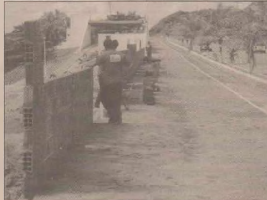
Muro está sendo erguido ao lado do Hotel Imirá, mas segundo Semurb não há irregularidade
