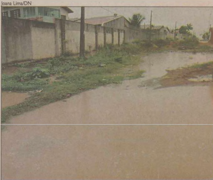
Em Nova Parnamirim, Rua Praia Baía Formosa ficou totalmente alagada
