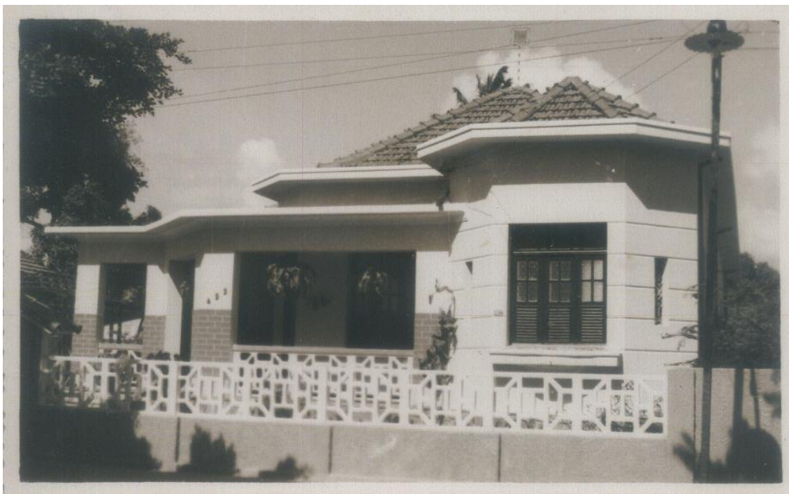
Figura 45 – Casa construída segundo os preceitos da época 48
