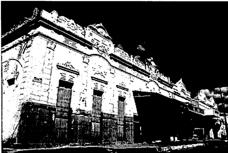
Antigo Cine Teatro Pedro Amorim – Seu lance de escadas e a calçadas eram “banhadas” pelas enchentes do Rio Açu. Localiza-se atrás da Igreja Matriz de São João Batista.
