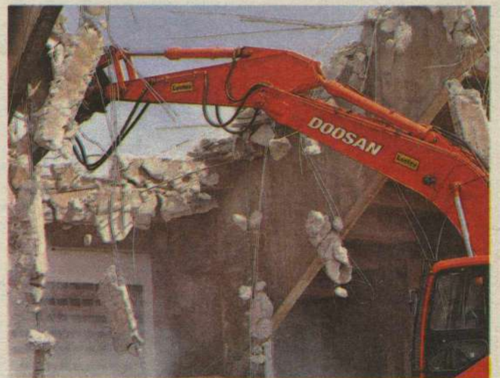
Processo de demolição vai durar 30 dias, depois começa a etapa do Machadão
