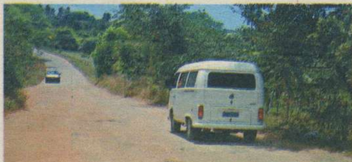
Motoristas reclamam da quantidade de buracos em trecho próximo a cidade
