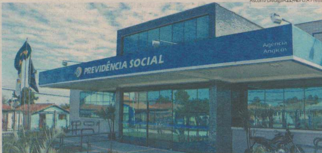
Ministério irá investir R$ 21,3 milhões na realização de obras e construção de novas agências no estado
