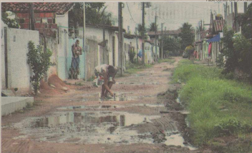
Rua Lagoa de Extremoz não tem drenagem, pavimentação ou esgoto. Valor médio cobrado é de R$ 150 por casa
