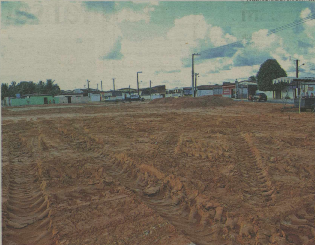
Unidade de Pronto Atendimento está sendo construída na Avenida Moema Tinoco, em Pajuçara, na Zona Norte
