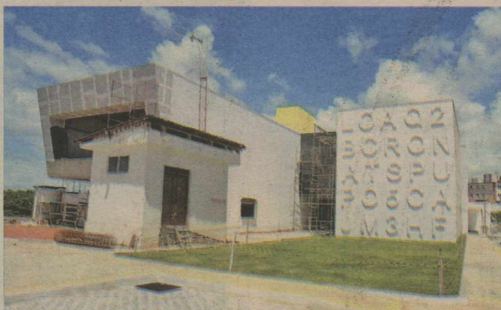
Com 12 mil metros quadrados de terreno, o novo DN será em local privilegiado
