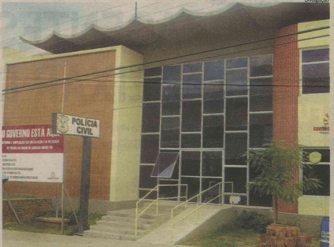
Prédio da DP de Currais Novos abriga 20 presos divididos em duas celas que deveriam abrigar apenas três pessoas cada
