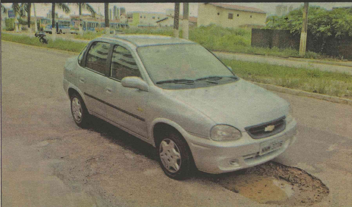
Trafegar na avenida é um teste para os pneus e a suspensão dos carros e um risco para a segurança dos motoristas
