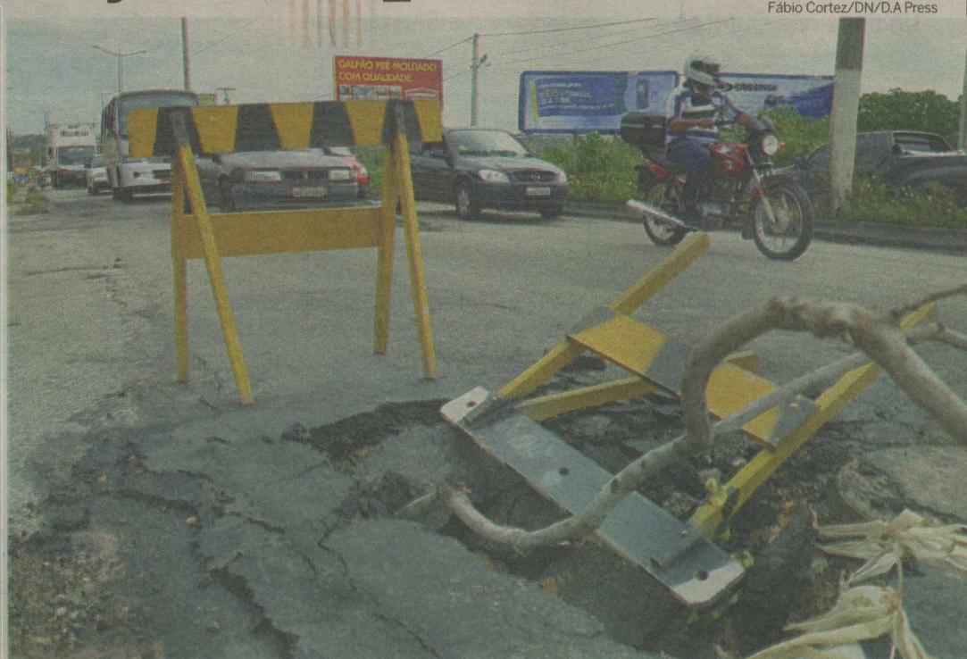
Obras de manutenção acontecerão em vias de Natal que tenham passado por serviços do órgão
