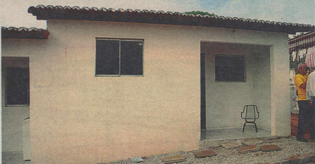
Casa onde o suspeito teria assassinado a própria esposa na frente dos dois filhos do casal, na Zona Norte de Natal
