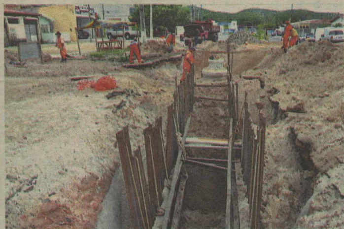
Escavações provocaram desvios no trânsito do bairro de Nova Descoberta
