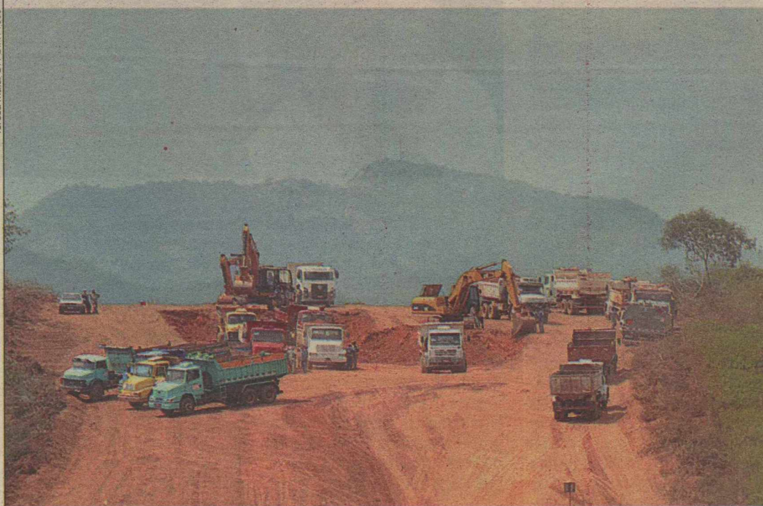
Obras da ferrovia Transnordestina, trecho Salgueiro-Trindade (PE), também está fora do cronograma
