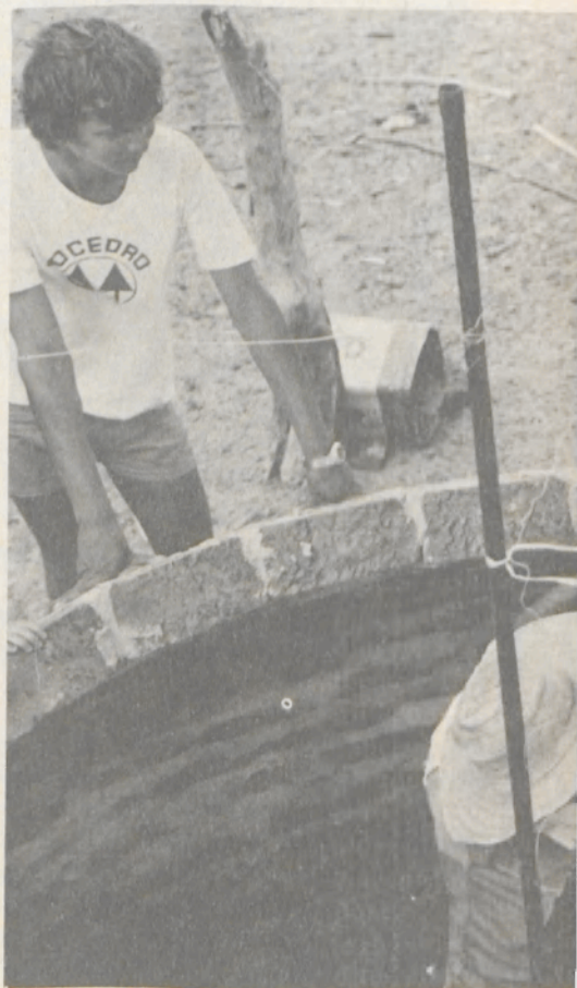
Melhorando as condições no campo
