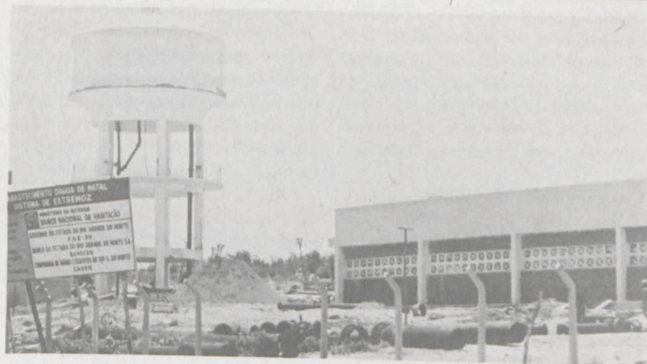
Um novo sistema de captação e distribuição de água está sendo implantado, aproveitando o manancial da Lagoa de Extremoz. Com isto, se atenderá a demanda da região de Igapó, para onde Natal se expande.
