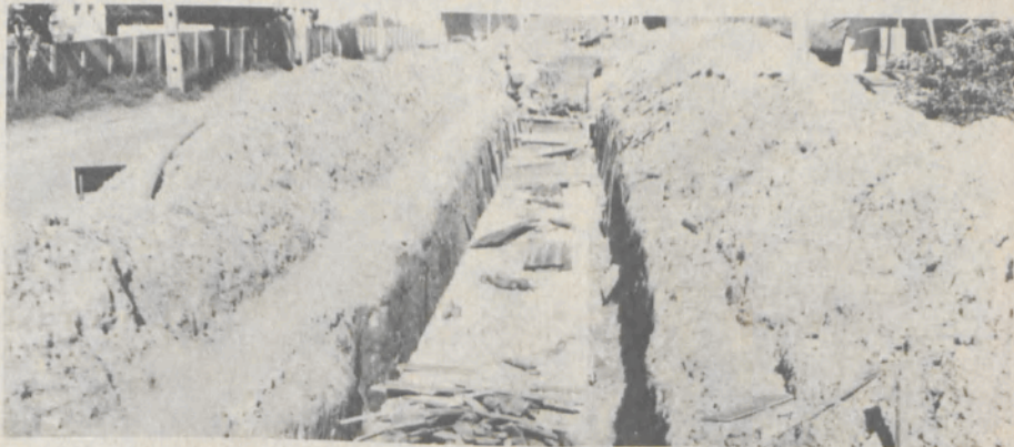
Vários bairros foram beneficiados com a execução de projetos de galerias pluviais. O projeto da Ribeira está sendo executado pelo DNOS, em convênio com a Prefeitura.
