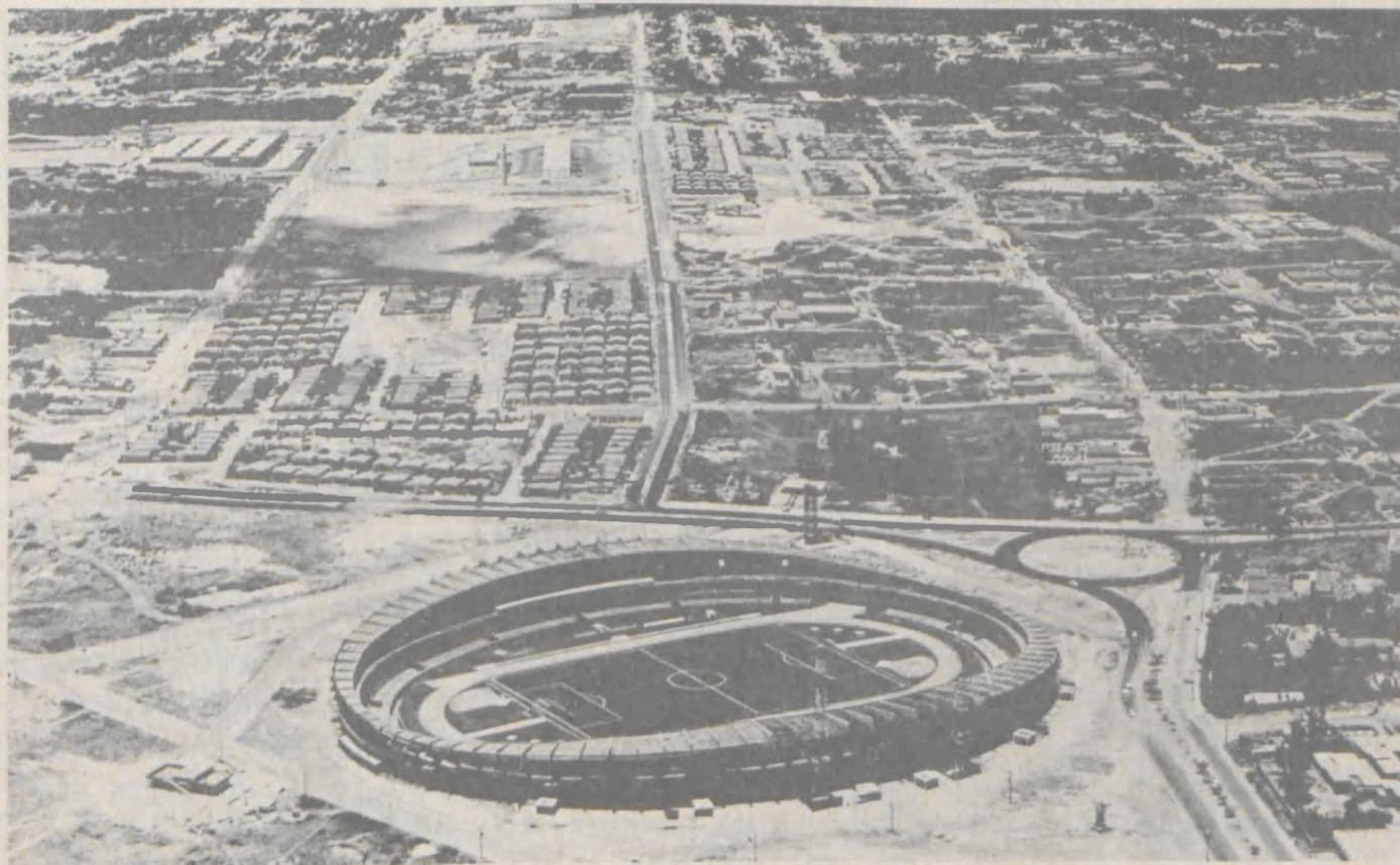
A maior atividade da FENAT está voltada para a manutenção do Estádio Castelo Branco e para o Palácio dos Esportes.
