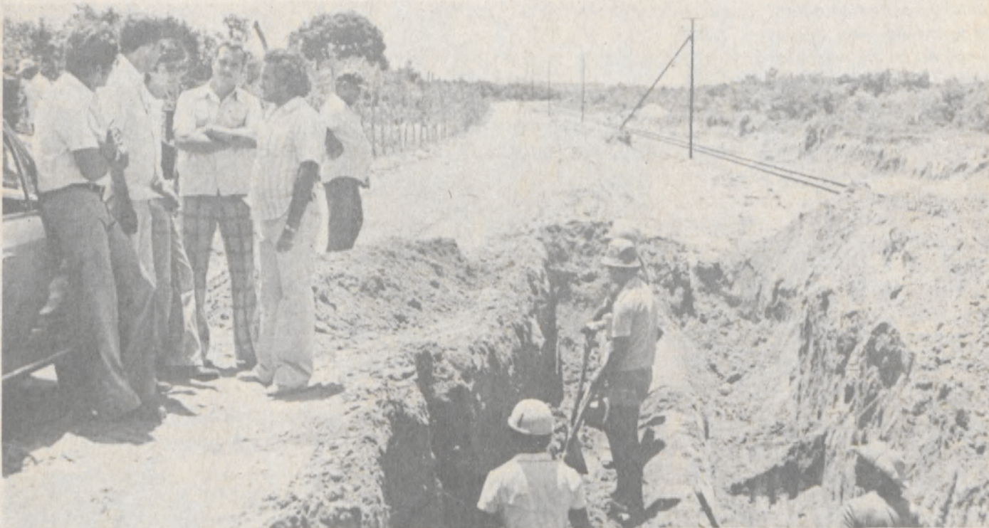
Os trabalhos de construção da adutora de Extremoz seguem dentro do ritmo e em breve estarão concluídos.
