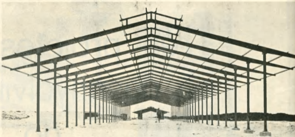
A construção civil de Lawar S/A já atinge mais de 60%. A conclusão está prevista para o segundo semestre do próximo ano.
