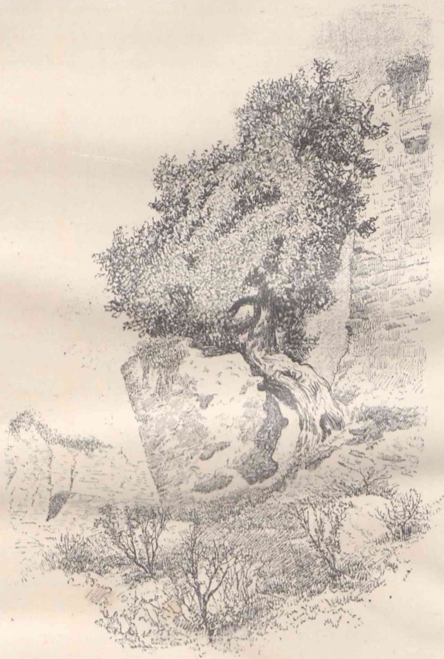
Ruinas das muralhas.
