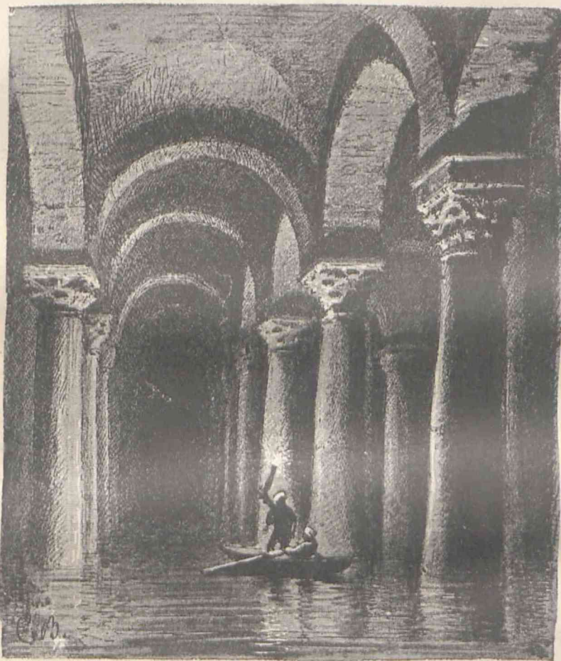
Cisterna em Constantinopla.
