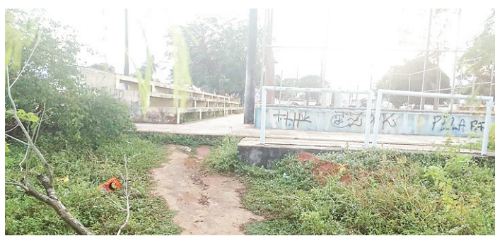
// Equipamentos de lazer estão sem condições de uso
