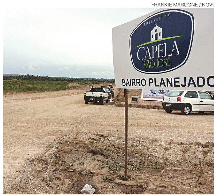
// Bairro Capela São José contará com infraestrutura urbana completa
