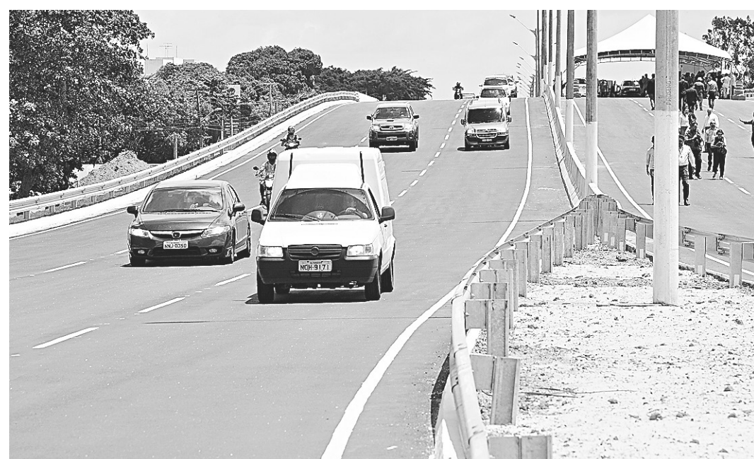
// Duplicação da BR-101: complexo terá quatro viadutos, um túnel, seis passarelas, uma passagem de nível
