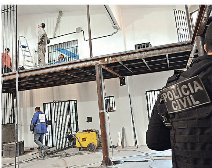
// Sobre as celas foram montadas passarelas para trânsito de agentes
