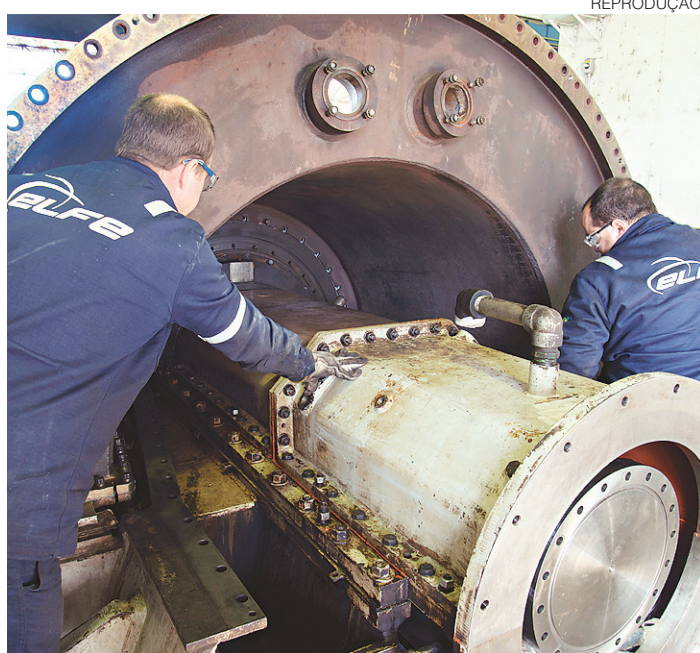
// Empresa expande ação para o setor de energia elétrica no RN
