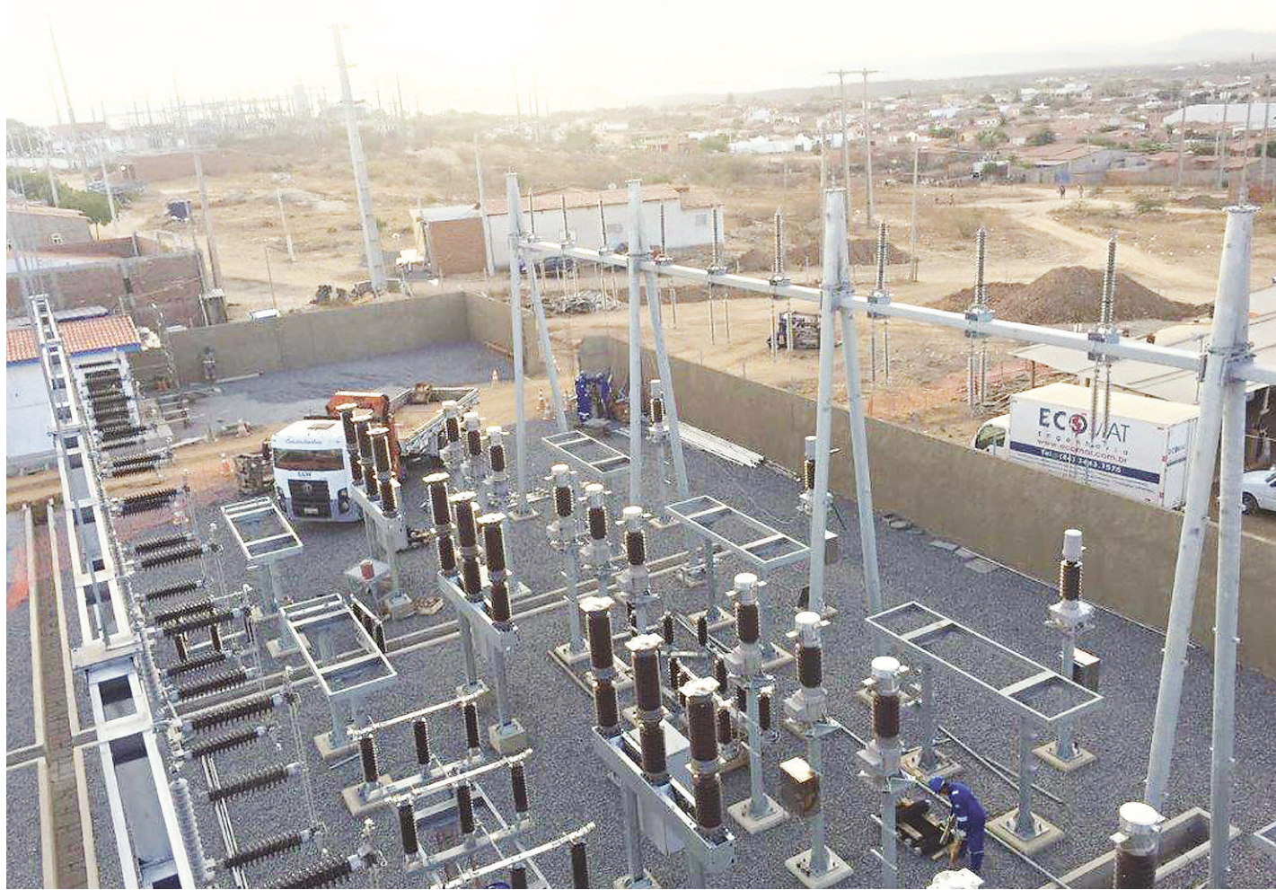
// Subestação de energia da Cosern, em construção no município de Currais Novos, no Seridó, é um dos investimentos da empresa em 2016
