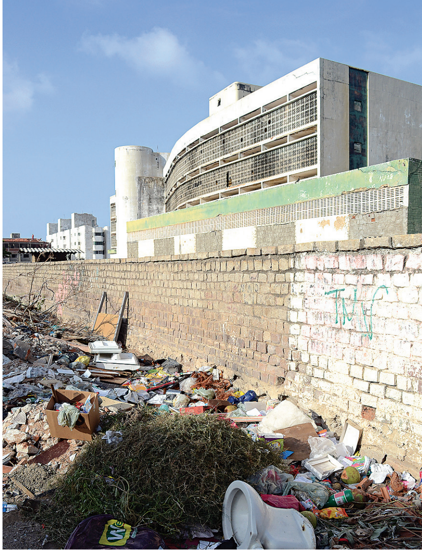
// Hotel abandonado acaba se tornando ponto para depósito de lixo
