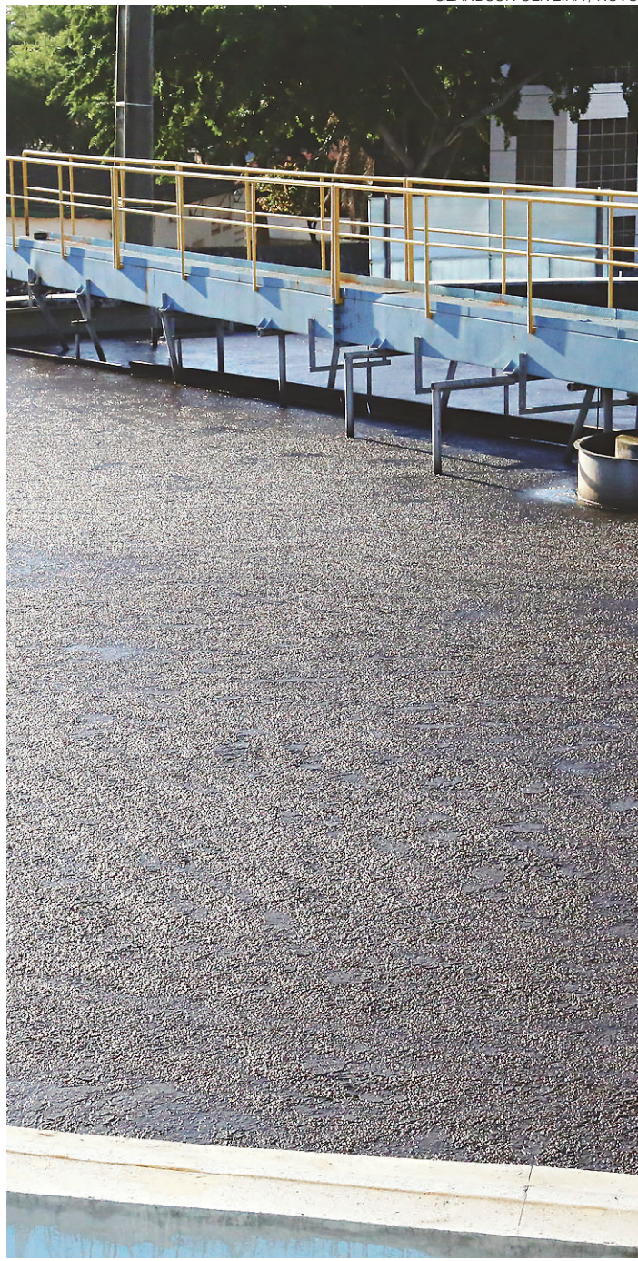
// Nova estação vai tratar até 1 mil litros de esgoto por segundo
