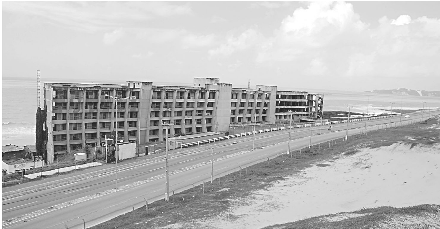
// O Hotel hoje é uma estrutura de concreto inacabada, na Via Costeira, que chama a atenção de quem passa no local pela aparência sinistra
