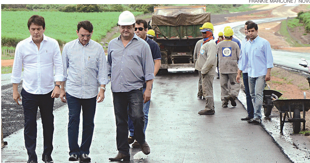
// Governador Robinson Faria, primeiro à esquerda da foto, vistoriou ontem obras de acesso ao aeroporto
