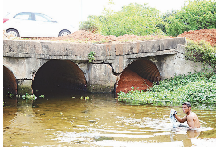
//Rompiemento do bueiro que canaliza Rio Doce ocorreu no dia 09
