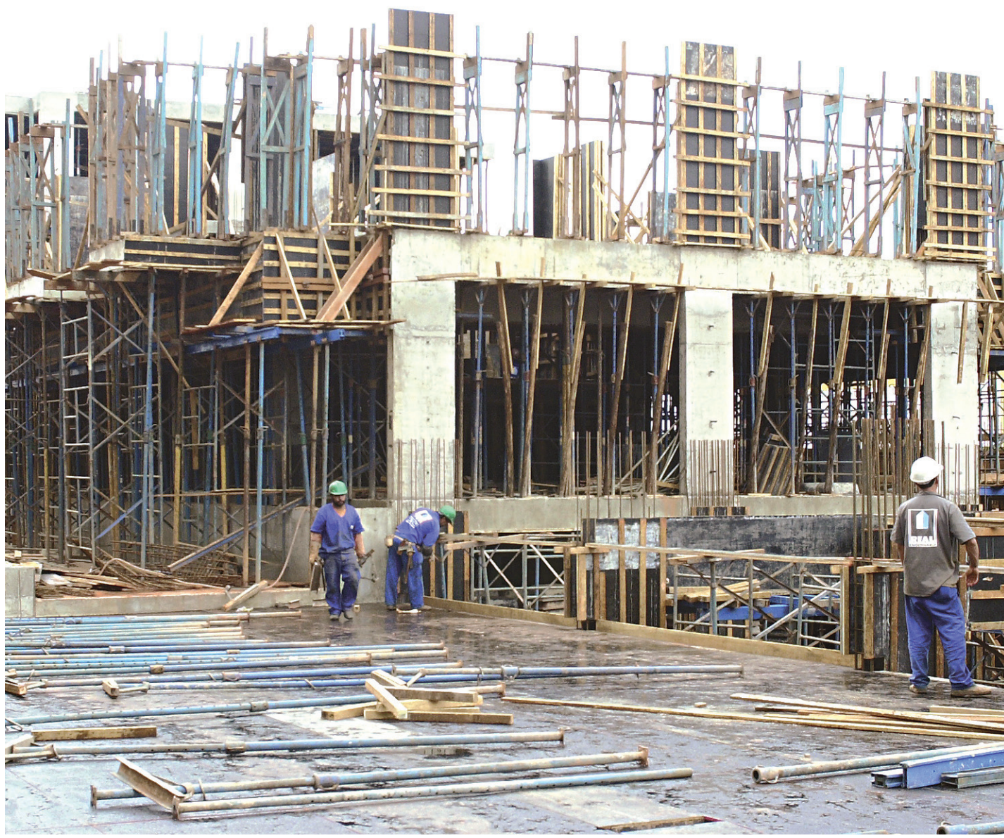
// Apesar das medidas beneficiarem a construção civil com R$ 10 bilhões, empresários locais criticam que ações só vão aumentar consumo
