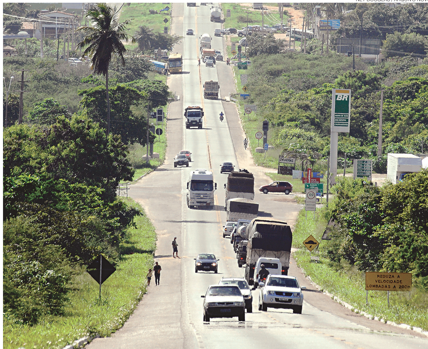
// Investimento previsto é de R$ 237 milhões e contempla a construção de viadutos, pontes e abertura de marginais
