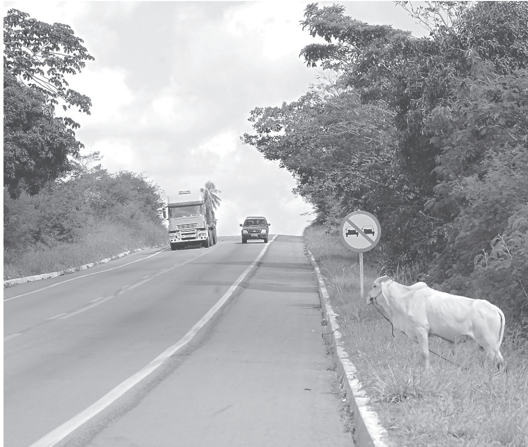
// Além de duplicar a rodovia, obra também contempla a construção de viadutos e pontes
