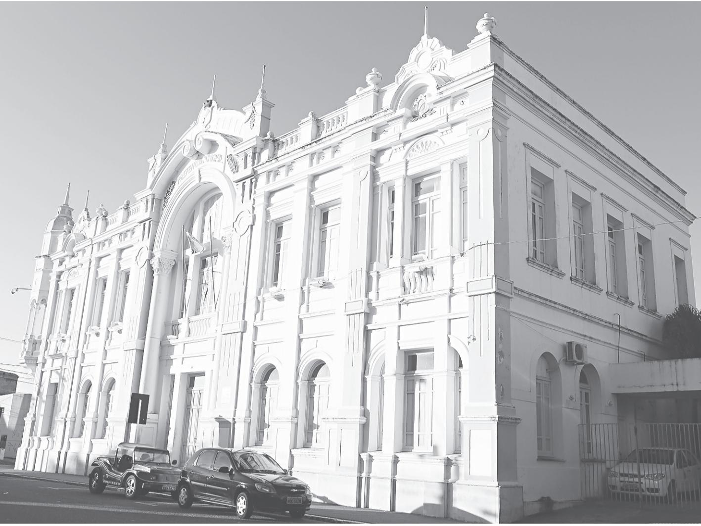
// Com parte de sua estrutura comprometida, segundo a Prefeitura do Natal, Palácio Felipe Camarão terá reforma contemplada no projeto
