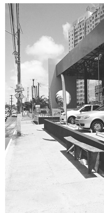
//AVENIDA ABEL CABRAL, BAIRRO DE NOVA PARNAMIRIM - Sem qualquer proteção, a instalação conta com um banco de madeira improvisado no local
