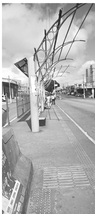
//AVENIDA BERNARDO VIEIRA, BAIRRO DE DIX-SEPT ROSADO - Diversas paradas de ônibus não têm mais a cobertura de proteção
