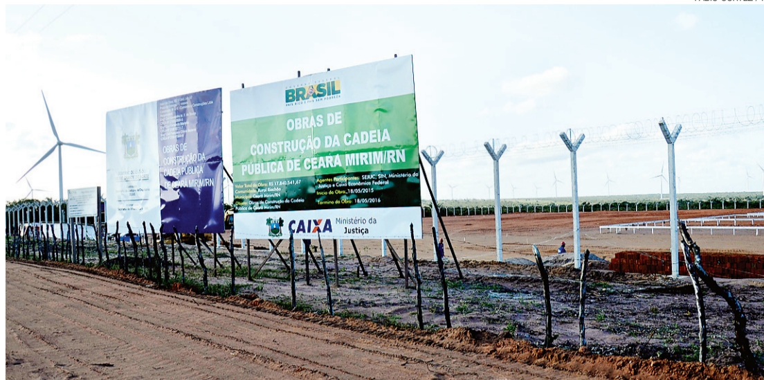
► Construção da Cadeia Pública de Ceará-Mirim vai iniciar a fase de fundações apenas esta semana
