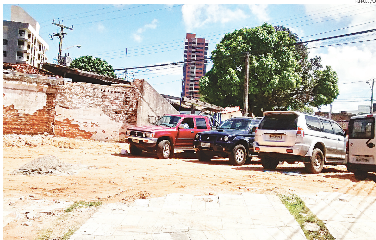
► Prédio não foi utilizado pelo MP justamente em virtude da ausência de vagas de estacionamento suficientes para o porte da edificação
