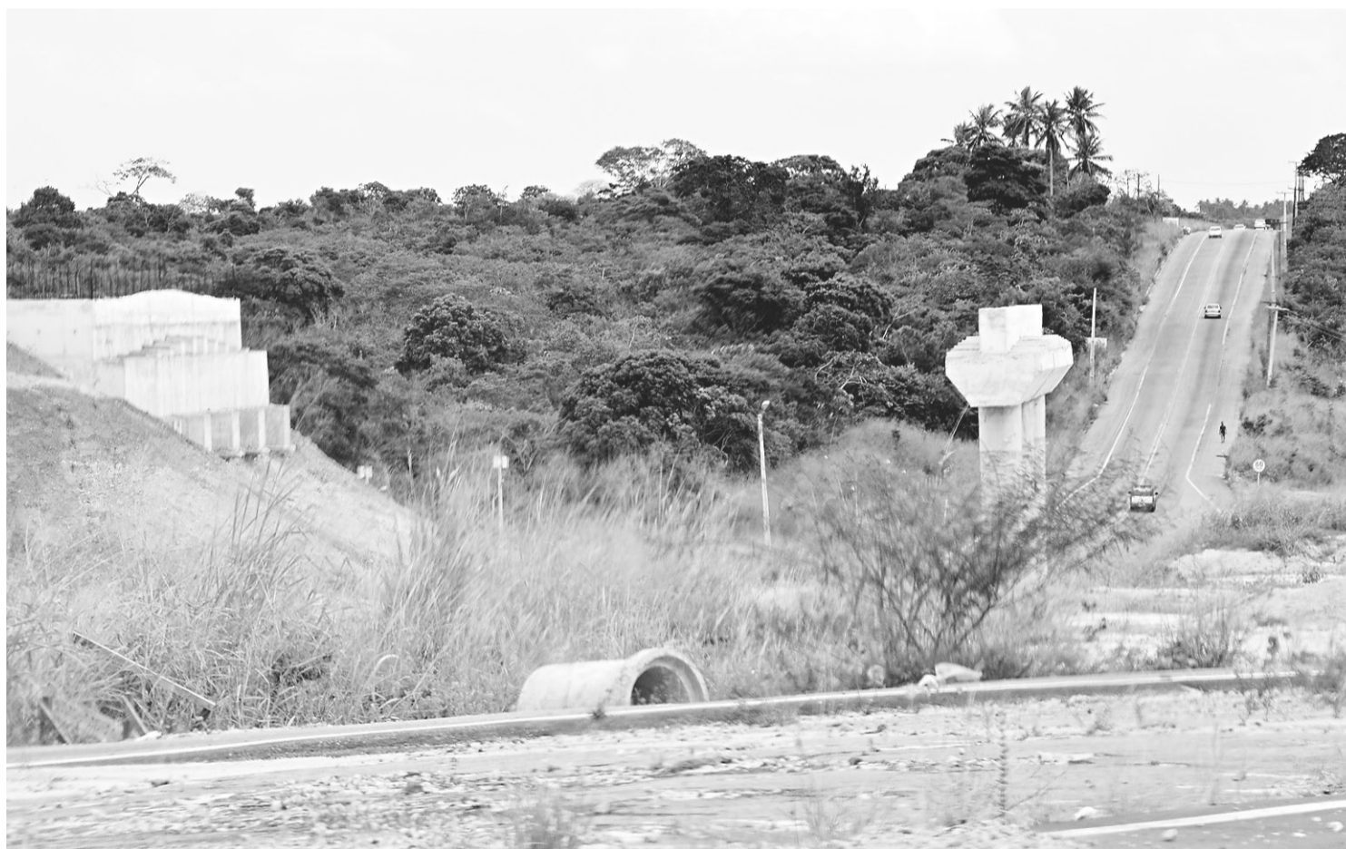
► Acesso norte faz a ligação da BR-406 e o novo aeroporto: expectativa de que as obras do viaduto sejam retomadas nesta semana e finalizadas até dezembro
