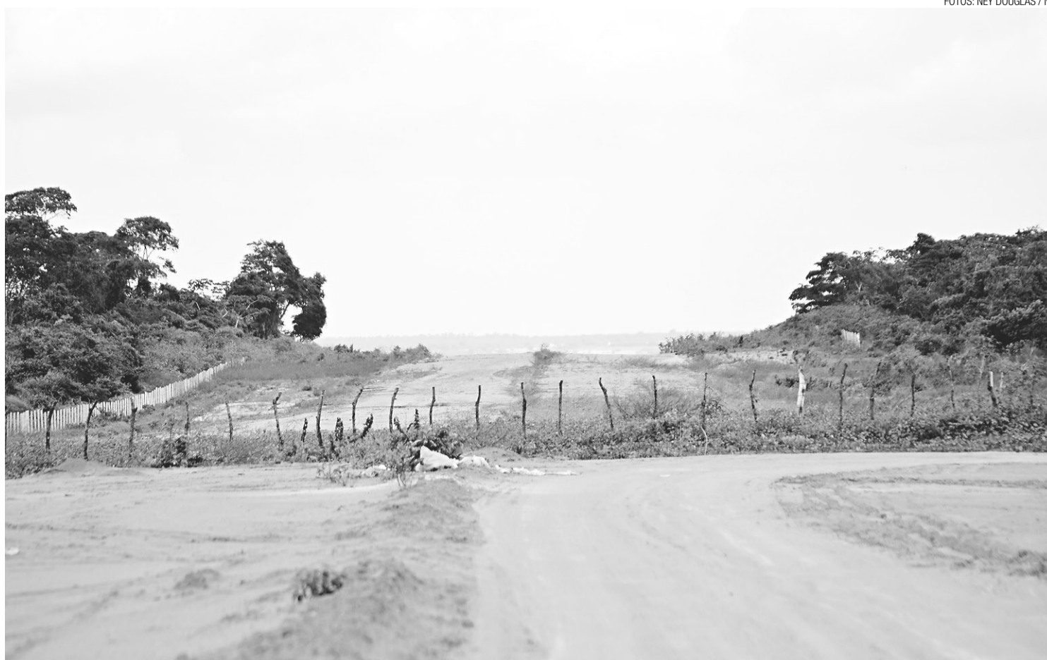
► Acesso sul faz a ligação entre Macaíba e o aeroporto através da rodovia BR-304: fechada por uma cerca de arame, a via está tomada por mato e erosão
