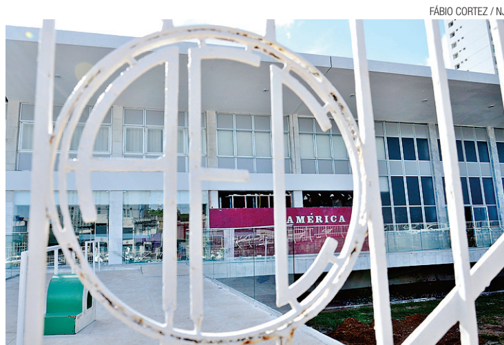
Principal espaço de eventos da cidade durante anos, sede social do América está reduzida à metade de seu tamanho original após permutas com construtoras
