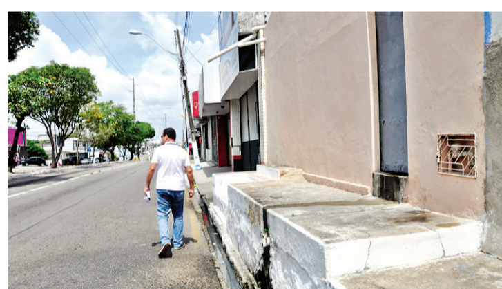
► Desníveis acentuados nas calçadas de Natal dificultam trabalho da Semopi
