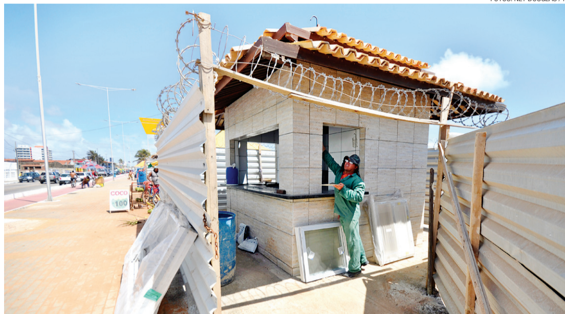
► Na praia do Meio, pisos dos banheiros e cerâmicas dos quiosques ainda estão sendo colocados
