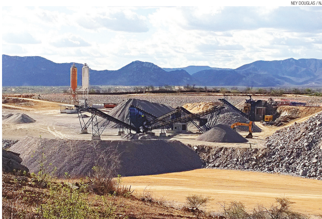
► União repassou para a Barragem de Oiticica, por meio do DNOCS, o montante de R$ 34,87 milhões
