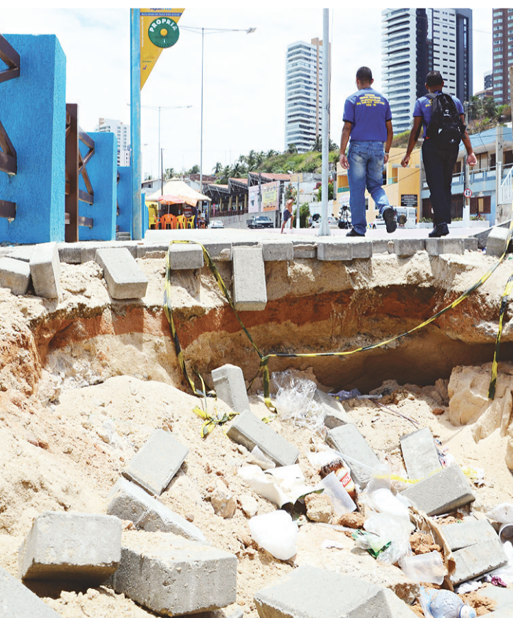
► Semov vai enxertar argamassa de cimento na base da estrutura do calçadão
