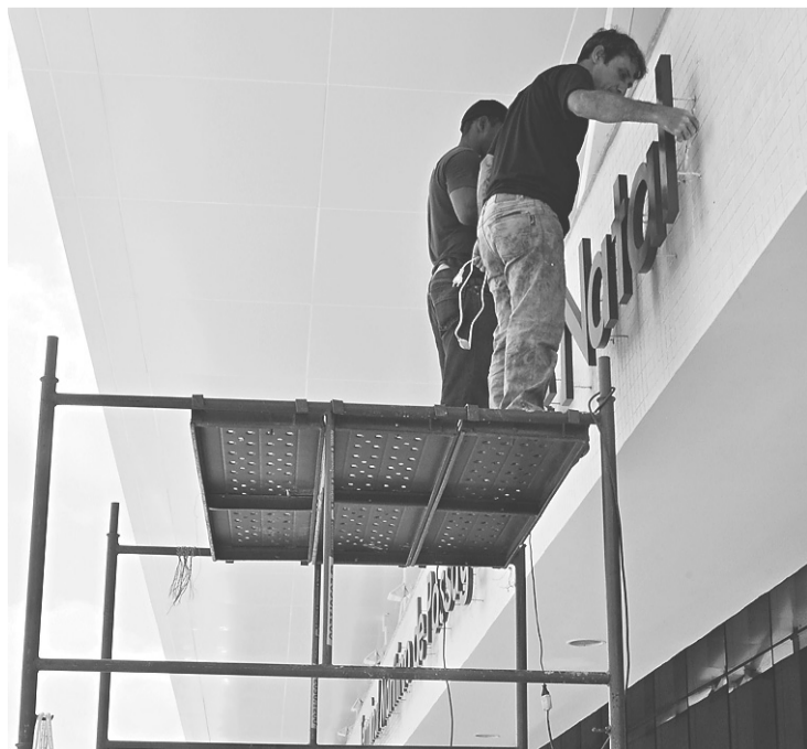
► Funcionários ainda realizam serviços de limpeza e finalização de detalhes
