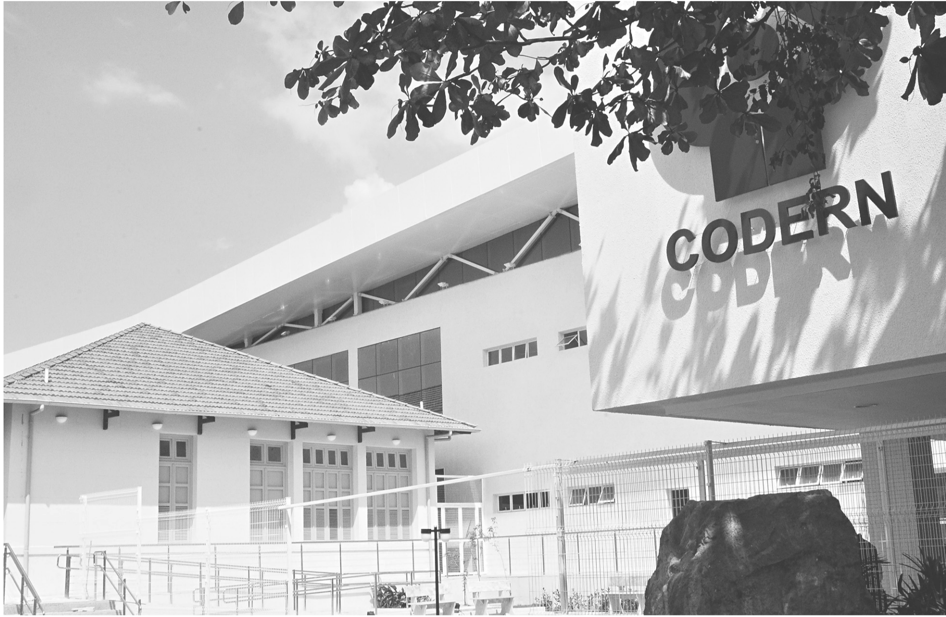
► Obra do prédio do Terminal de Marítimo de Passageiros foi iniciada em abril de 2012 e custou R$ 72,5 milhões aos cofres públicos
