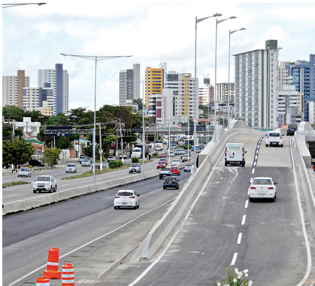
▶ Liberação do tráfego deixou alguns motoristas confusos quanto ao uso do viaduto e sobre sua finalidade
