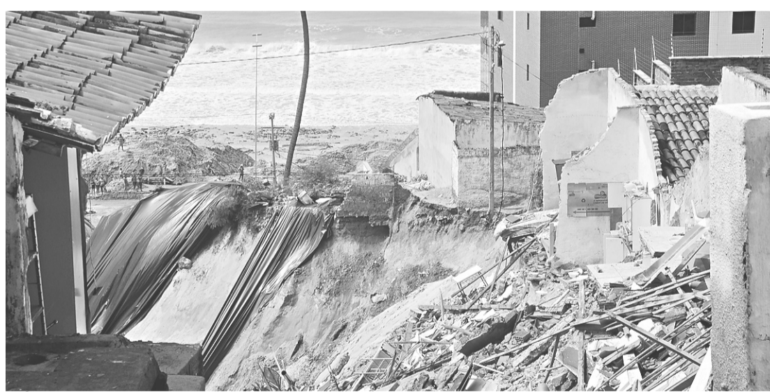
► Área de risco agora atinge outras ruas do bairro de Mãe Luíza, onde várias casas desabaram ou foram interditadas
