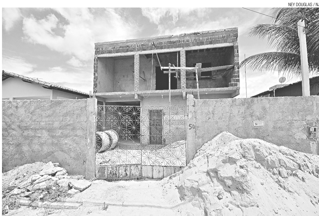
► Casa em construção no bairro de Passagem de Areia, em Parnamirim, onde o flagrante foi registrado em vídeo
