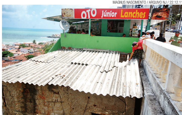
Local era ocupado por construções irregulares que foram demolidas
