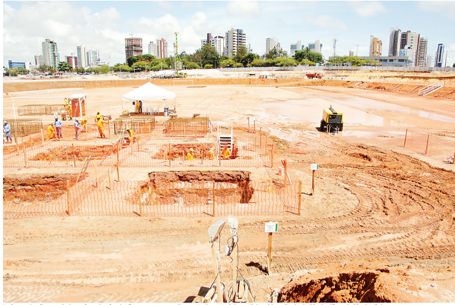
Arena das Dunas ainda na fase das fundações, com o aproveitamento do material que tinha sido retirado do Machadão e do Machadinho
