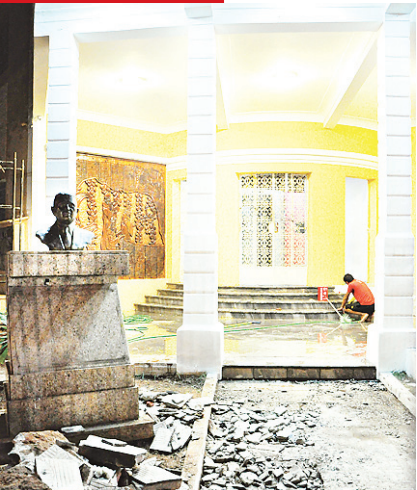
► Após ocupação, reforma na casa do povo
