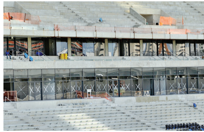
► Vidraças são instaladas nos camarotes
