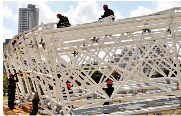
► Operários dão ritmo à instalação das coberturas
